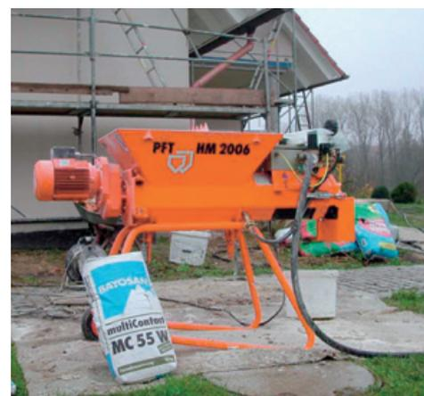
Der verwendete Haftmörtel BAYOSAN multiContact MC 55 W zeichnet sich durch seine gute Maschinengängigkeit aus. Mit dem Horizontalen Durchlaufmischer PFT HM 2006 wurde der Mörtel chargenweise angemischt.
