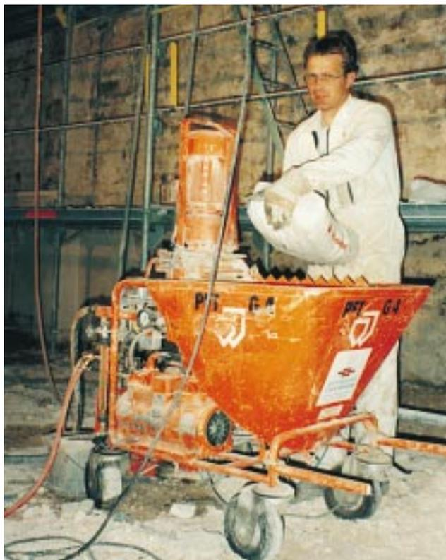
Die PFT G 4 wurde mit verschiedenen Pumpeneinheiten an die jeweiligen Teilaufgaben angepasst: verpresst wurde mit der PFT Schneckenpumpe D 3-5, verputzt mit dem Typ D 6-3. Gute Dienste leistete der PFT Mörteldruckmanometer, der beim Verpressen als Druckbegrenzer fungierte.
