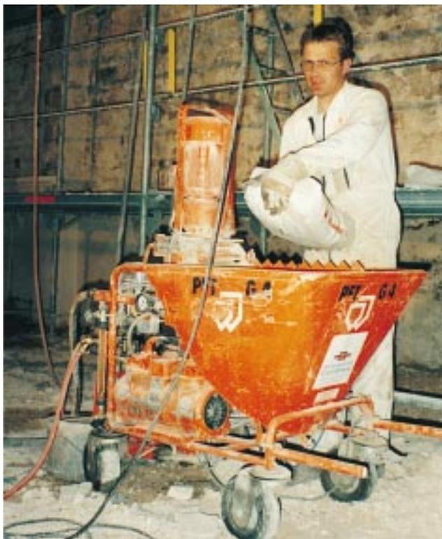
Die PFT G 4 wurde mit verschiedenen Pumpeneinheiten an die jeweiligen Teilaufgaben angepasst: verpresst wurde mit der PFT Schneckenpumpe D 3-5, verputzt mit dem Typ D 6-3. Gute Dienste leistete der PFT Mörteldruckmanometer, der beim Verpressen als Druckbegrenzer fungierte.
